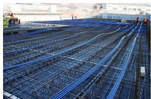
soletta bidirezionale è caratterizzato dall'assenza di travi e permette quindi di avere l'intradosso piano, con grande vantaggio per le distribuzioni impiantistiche che sono inserite prevalentemente a controsoffitto.
