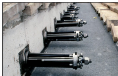
Dispositivi dissipativi con Leghe a Memoria di Forma
