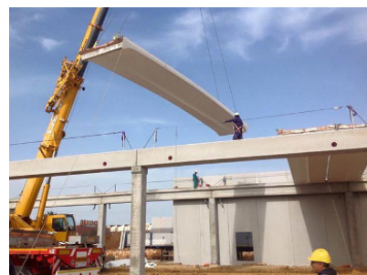
Assemblaggio in cantiere di struttura prefabbricata
