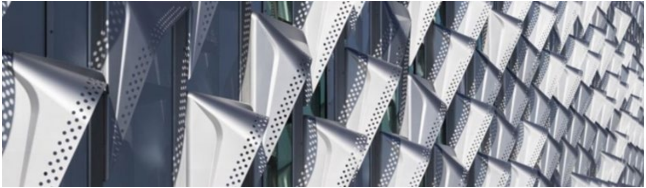
Figura 7 - Frangisole esteso in pannelli modulari di acciaio stampato
