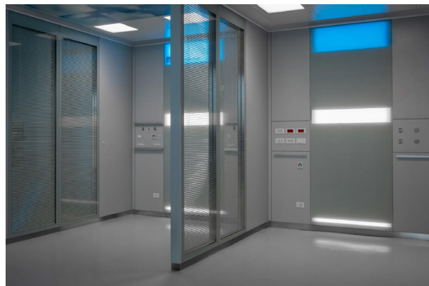
Le veneziane inserite all'interno del vetrocamera, fungono da divisori tra le aree del laboratorio, offrendo massima concentrazione e passaggio controllato della luce naturale.
