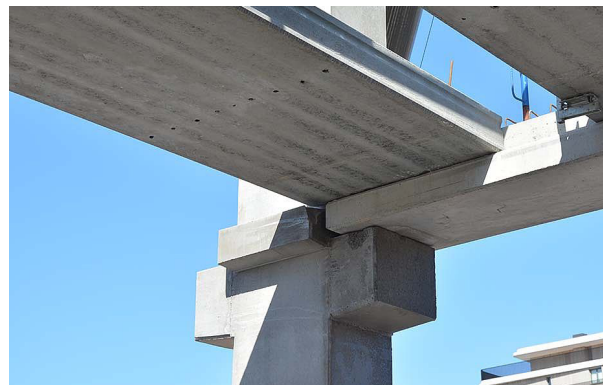
Fig. 13: Foto del nodo trave-pilastro in cls prefabbricato
