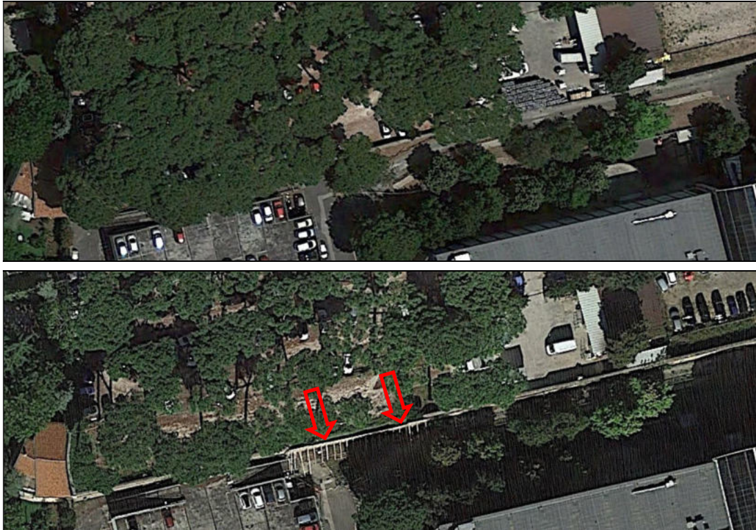
Confronto fotografie aerea, in alto fotografia aerea del 2015, in basso fotografia aerea del 2016 si notano i puntellamenti del settore di muro crollato (freccie rosse)
